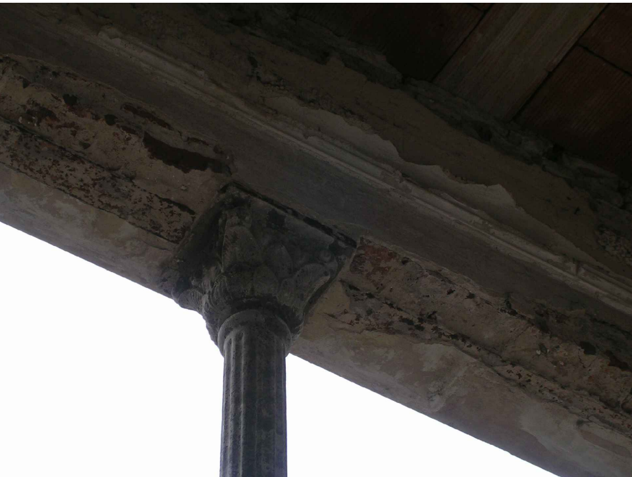
NOTA: RASTROS DE MOLDURAS REGISTRADOS EN EL PATIO NORTE, CORRESPONDIENTES A PLANTA ALTA.
